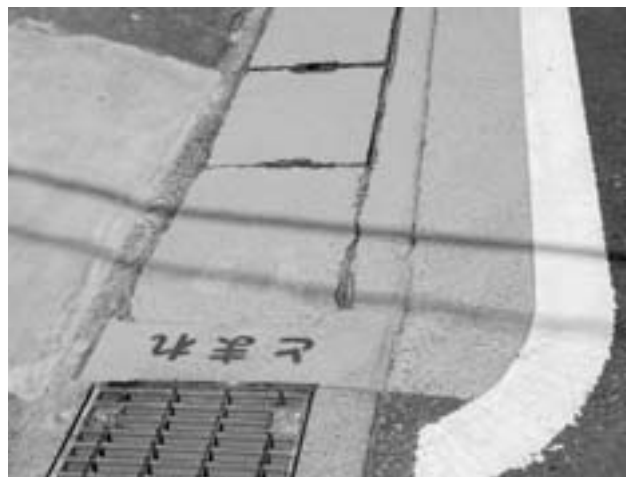
整備される遮熱舗装歩道
