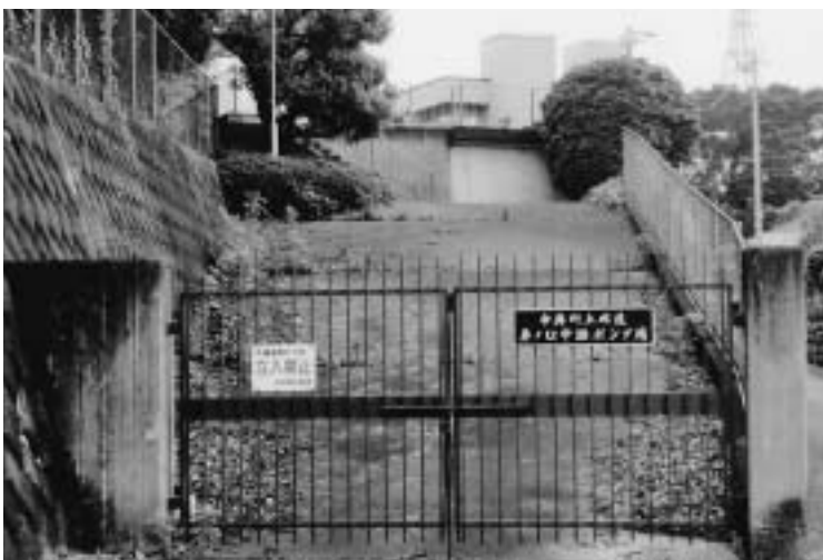
休止状態の井ノ口中継ポンプ場
