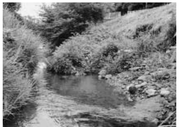
中村川上流の浸食された箇所
