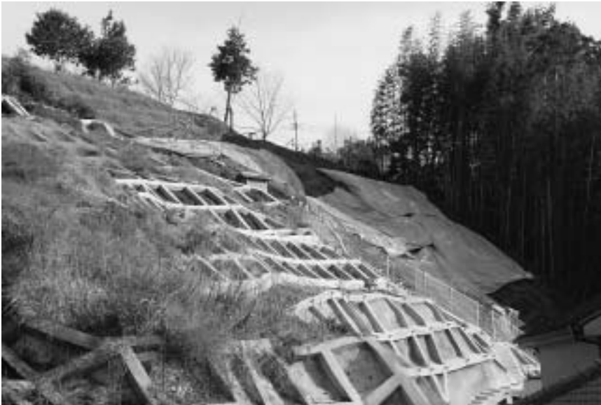
急傾斜地崩壊防止工事（比奈窪地区）
