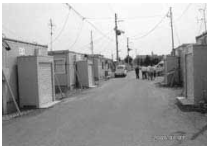
小千谷市の応急仮設住宅
