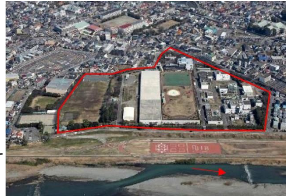
酒匂水再生センター
