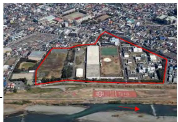
酒匂水再生センター
