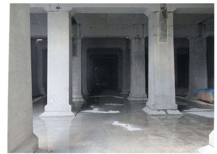
⑧ プレキャスト調整池工（Ⅱ期） 調整池内
