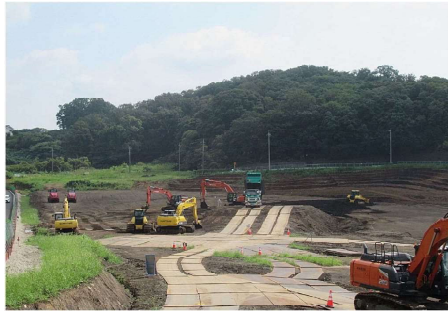
① 土工工事（盛土工、2ゲート側） 全景
