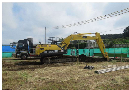
⑦ 通過雨水管工（□1400） 管路掘削
