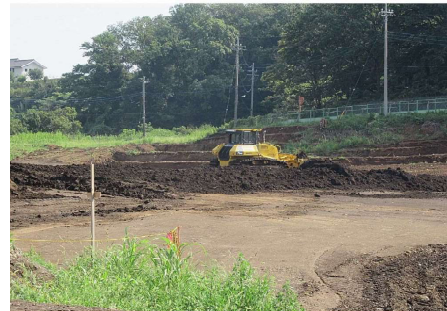
③ 土工工事（盛土工、2ゲート側） 敷均し
