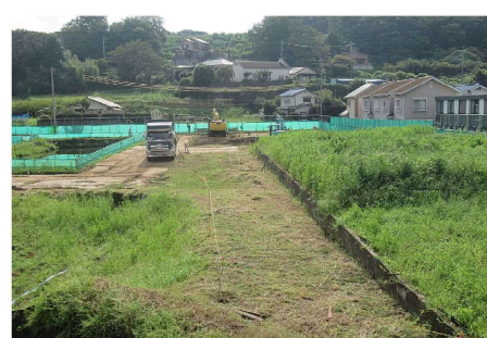
⑥ 通過雨水管工（□1400） 全景
