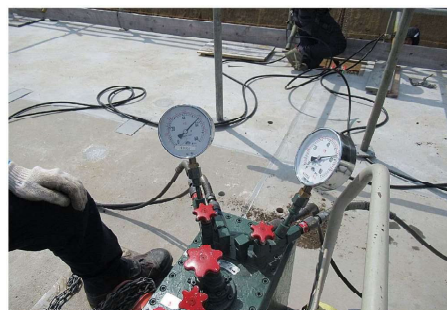
⑪ プレキャスト調整池工 横梁緊張（油圧ポンプ・ゲージ）
