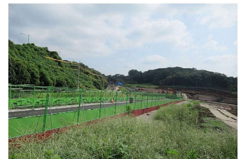
⑫ 仮設工（東名側道切回し道路） 全景
