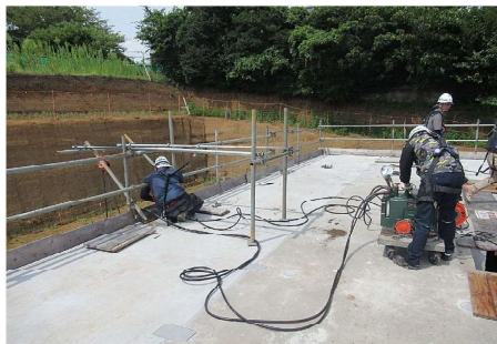
⑨ プレキャスト調整池工 横梁緊張全景
