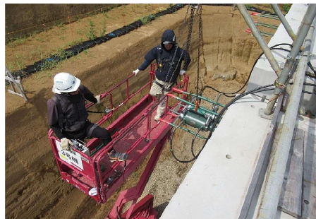
⑩ プレキャスト調整池工 横梁緊張（緊張ジャッキ）
