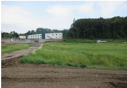
⑤ 土工工事（盛土工） 土砂ダンプ場内走行
