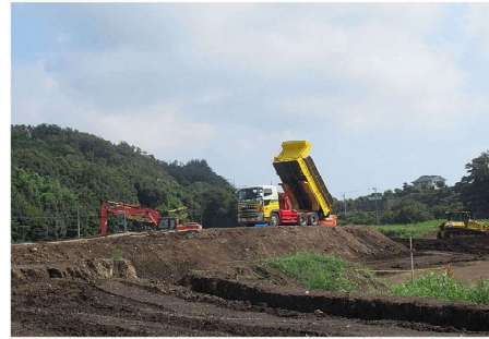
② 土工工事（盛土工、2ゲート側） 土砂受け
