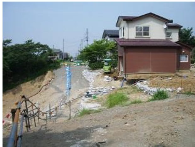
図-4.6 地震による造成宅地の被害の例
