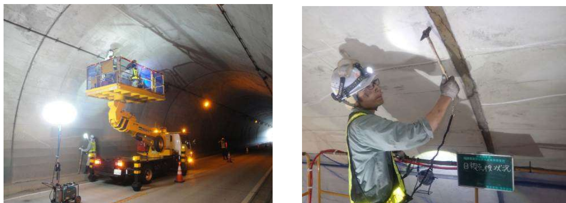
写真6-1 道路トンネル点検状況
