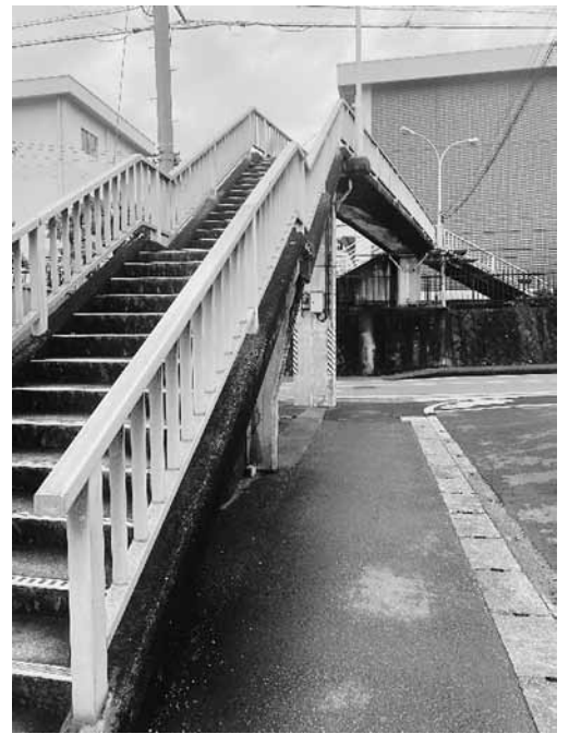
築54年の井ノ口小学校歩道橋
