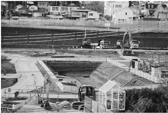
住宅の近くで工事が進む宮原地区
