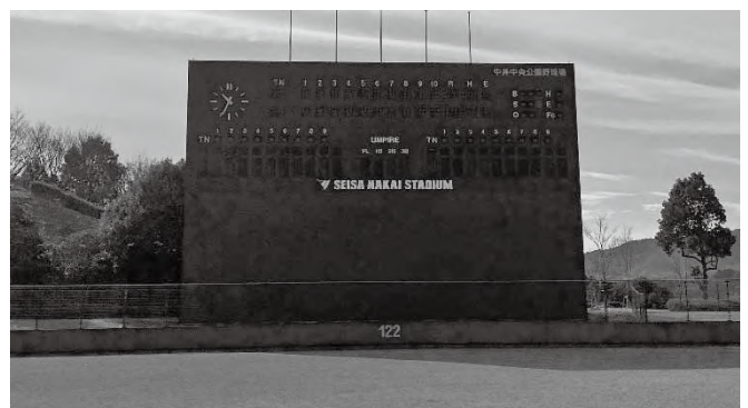
▲改修前の中央公園野球場スコアボード
