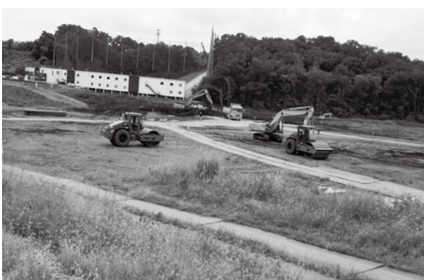
活力あるまちへ、造成が進むインター周辺
