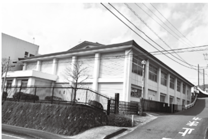
今年度、空調設備が設置予定の井ノ口小学校体育館
