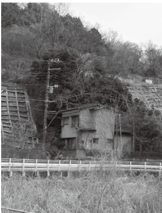
急傾斜地崩落防止事業の未整備箇所
