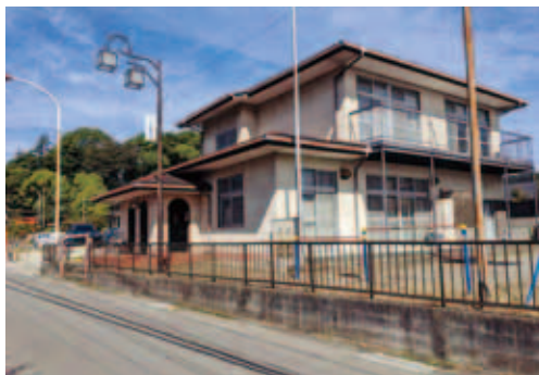
地域集会施設・中村下会館
