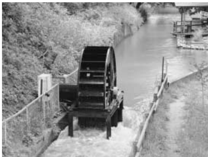
小水車発電（長野県波田町）
