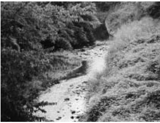
豪雨による崩壊が心配される中村川（富士見橋上流）
