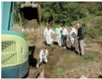
放射性物質保管替え作業現地確認
