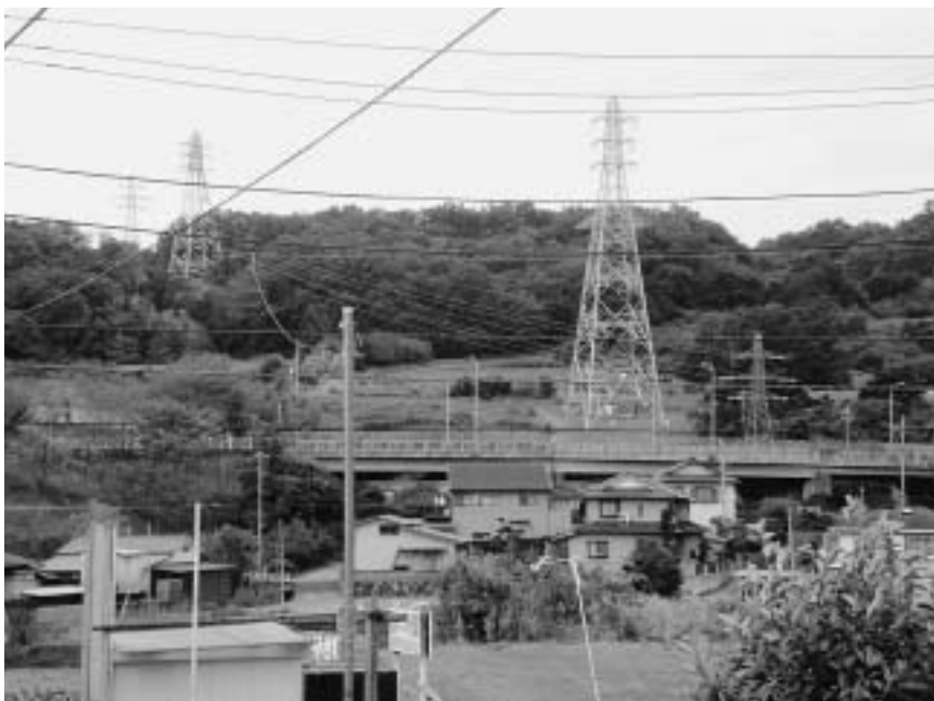
メガソーラー建設地
