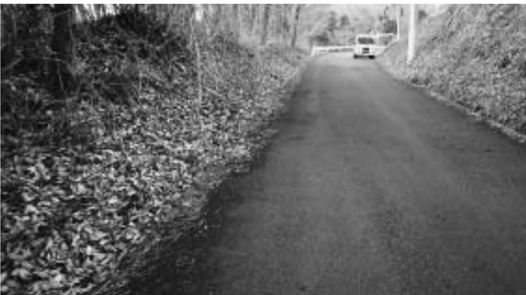
落葉が堆積し路面と区別がつかない側溝（境原幹線で）
