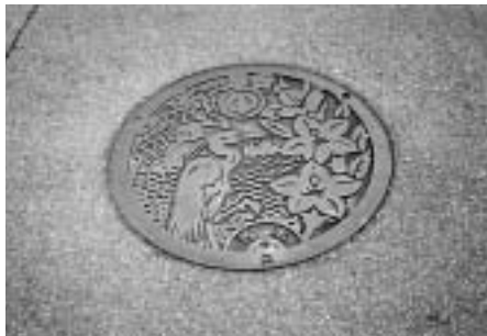
公道に敷設されている公共下水道マンホールのふた
