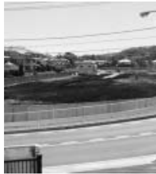
大型店舗工事の様子
