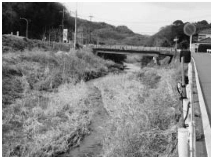
河川整備が必要な中村川
