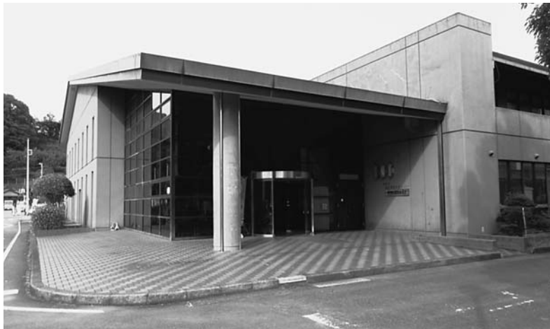
バリアフリーがされていない老朽化する改善センター
