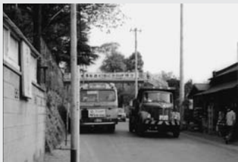
昭和46年頃の井ノ口歩道橋
