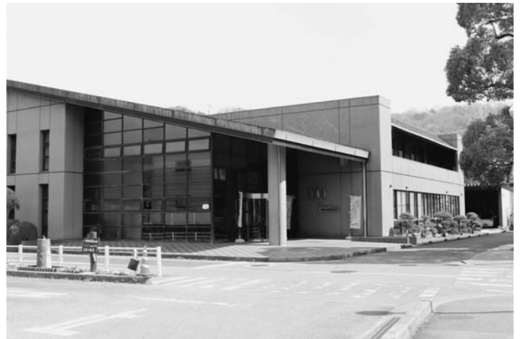
改善センターに障がい者施設補修を
