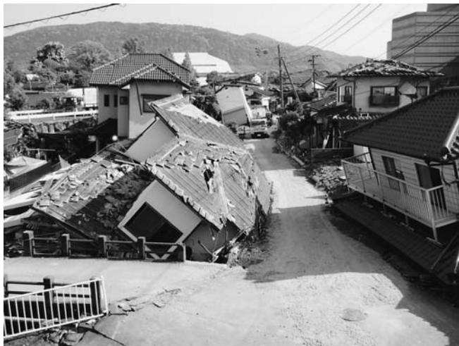
平成28年 熊本地震 益城町
