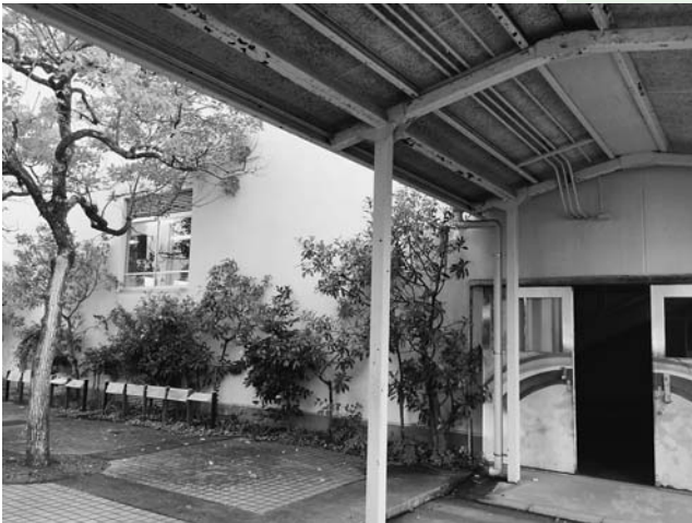
中井中学校格技棟
