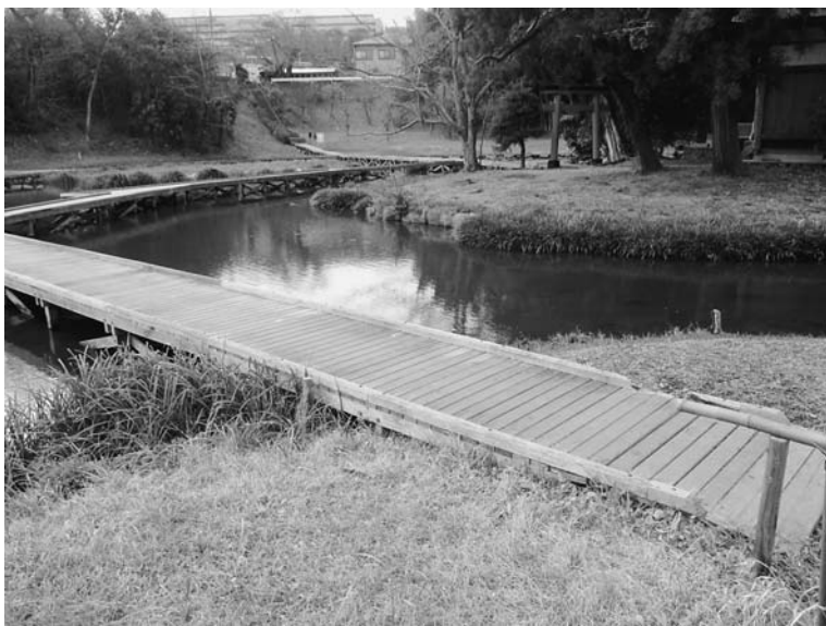
改修が予定される厳島湿生公園の木道
