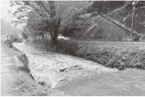
令和元年台風19号に伴い増水した藤沢川
