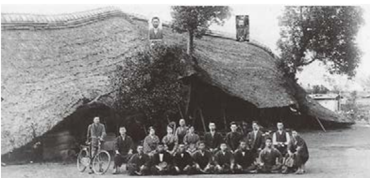
関東大震災で被災した井ノ口尋常小学校 (中井町耐震化促進計画より)
