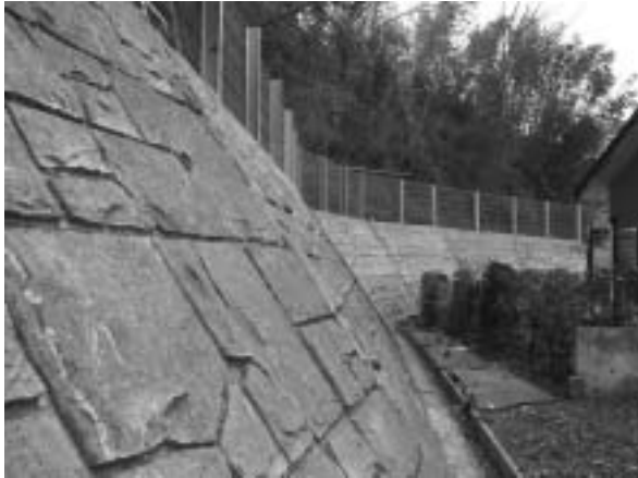
進められる崩壊防止対策
