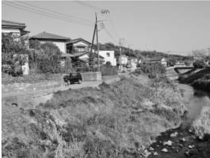
未整備の中村川沿い（北田）
