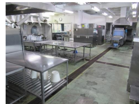
学校給食センター調理室
