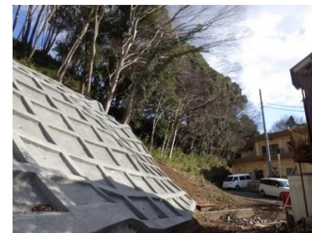
急傾斜地（比奈窪地区）
