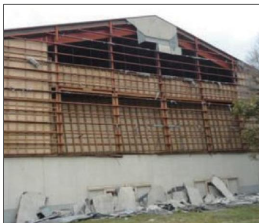
図 3-6 非構造部材の被害事例
