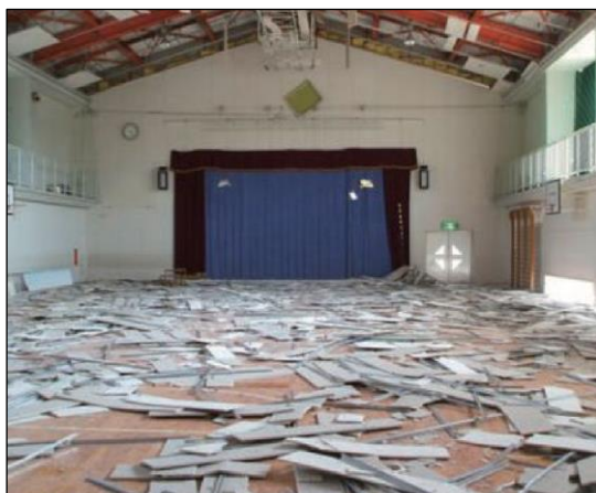
図 3-6 非構造部材の被害事例
