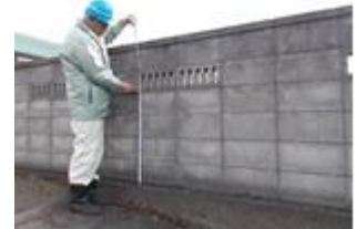
ブロック塀の点検
