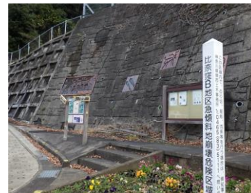
※急傾斜地崩壊防止工事
