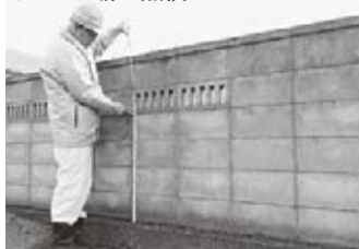
ブロック塀の点検
