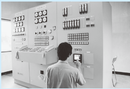
町環境上下水道課職員が、日々町内の配水池等水道施設を点検・監視しています。
