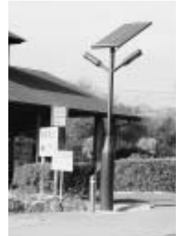
防災・防犯対策のため設置された中井中央公園のソーラー照明灯
