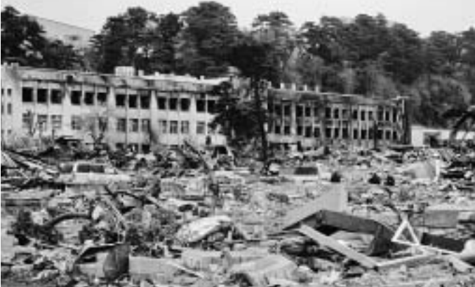
津波と火災の被害を受けた門脇小学校
