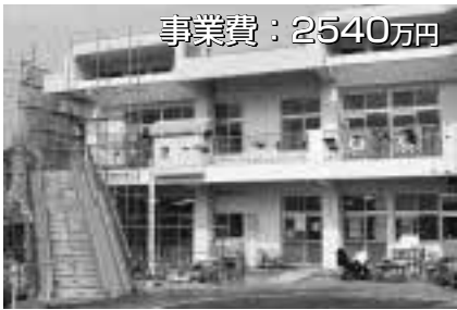
中村保育園耐震補強・改修工事 保育環境の整備充実を図ります。
