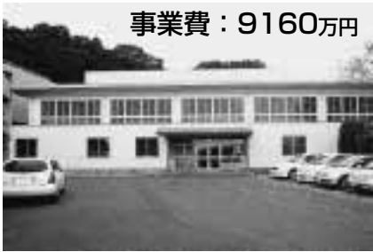
学校施設耐震補強・改修工事 中村小・中井中学校体育館を整備しました。
