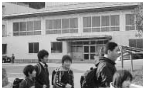
中村小・中井中学校体育館等を改修します。
