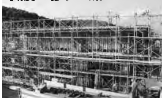
井ノ口保育園園舎移転新築事業 平成19年度完成に向けて、園舎の建設を進めています。
