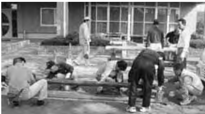
境コミュニティセンター 屋外テーブル・ベンチの塗装作業
