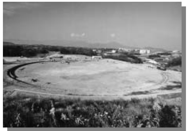
中井中央公園建設工事 (平成9年野球場完成) ※写真は野球場敷地造成工事
